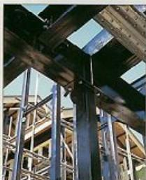
公庫基準の200mに比べて実に1.75倍。幅350mm・厚さ4.5~6mmのH鋼梁が建物のゆみを防ぎ耐震・耐風性を高めます。
