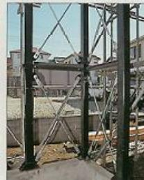
骨太の鋼製筋交いを上下に組み合わせたダブルプレース補強。公庫基準の直径13mmと比べても、その強さは歴然です。
